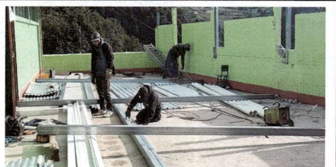
Foto 4: Inicio de colocación de estructura de metal y lámina troquelada aluzinc calibre 26
