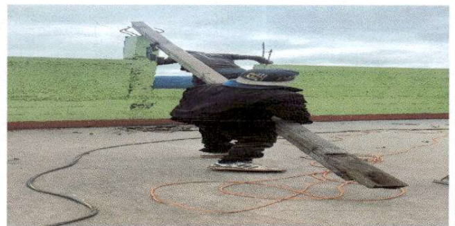
Foto 2: Sustitución de lámina por lámina troquelada aluzinc calibre 26 y sustitución de estructura
