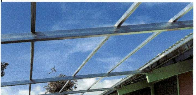
Foto 5: Sustitución de soporte de metal
