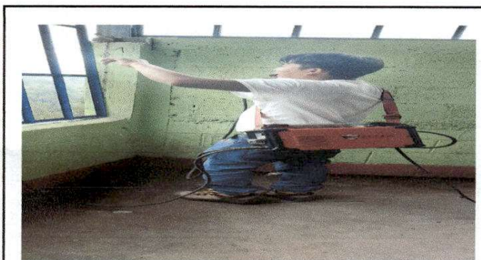
Foto 3: Instalación de estructura de metal
