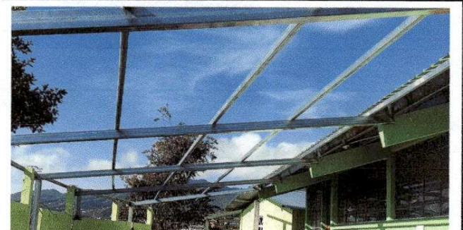
Foto 6: Sustitución de soporte de metal
