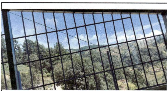
Foto 4: Instalación de estructura de metal
