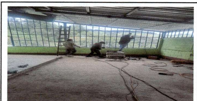
Foto 5: Instalación de vidrios
