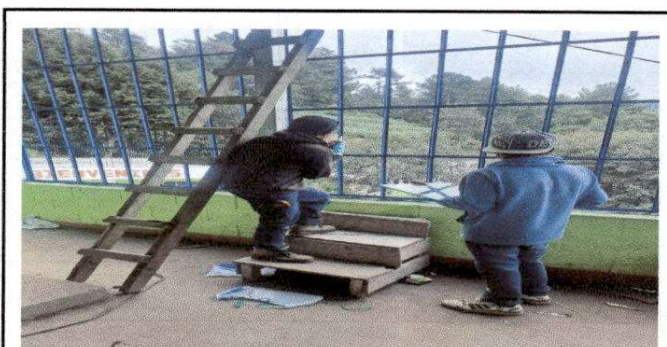
Foto 6: Instalación de vidrios
